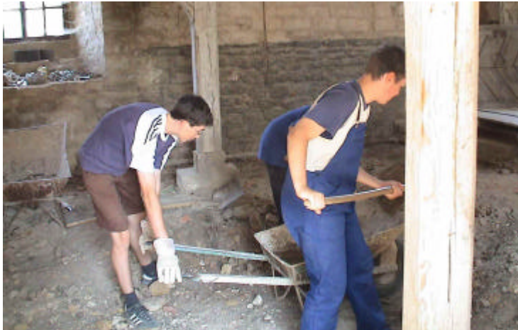
Auf der Baustelle
