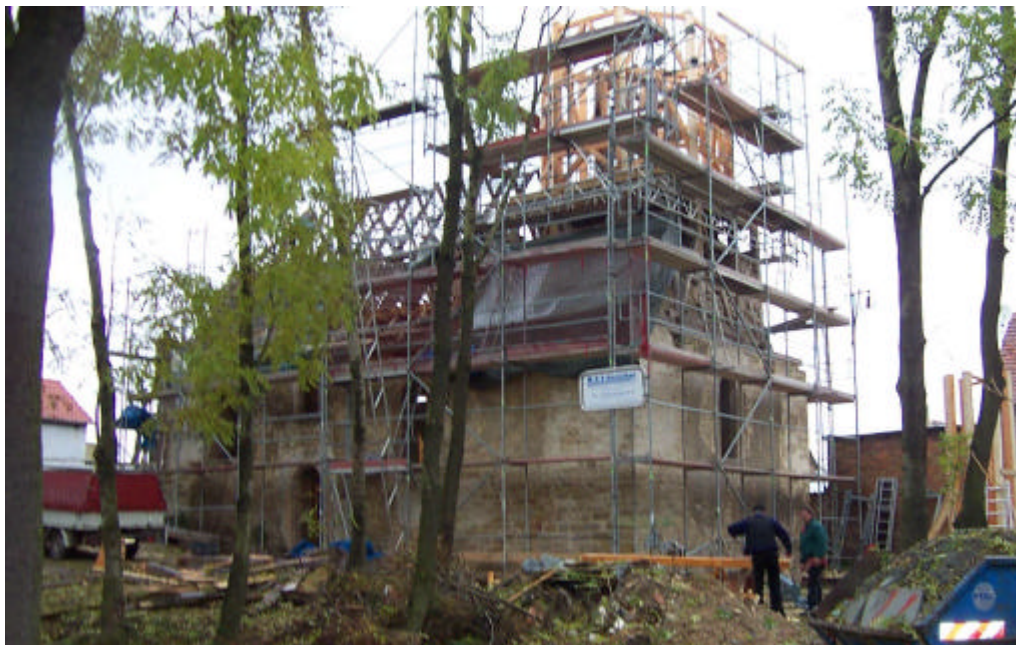
Der Glockenstuhl nimmt wieder Form an!
